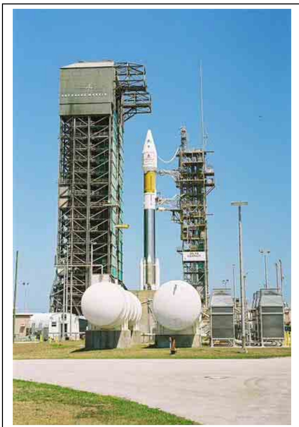
A torre móvel de serviço da plataforma de lançamento SLC-36B do Cabo Canaveral AFS, afasta-se do foguetão Atlas-2AS na fase final da contagem decrescente para a missão AC-166. Imagem: ILS.
